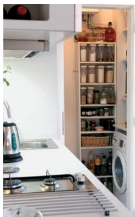
Pohled přes kuchyň do technického zázemí, kam se kromě pračky, kotle, lednice vejde i spousta maličkostí.
