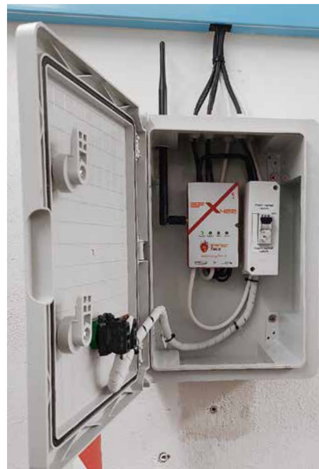
Wi-fi připojení elektronické ekvitermní regulace s možností dálkového monitoringu a sběru dat na PC + jistič napájení
