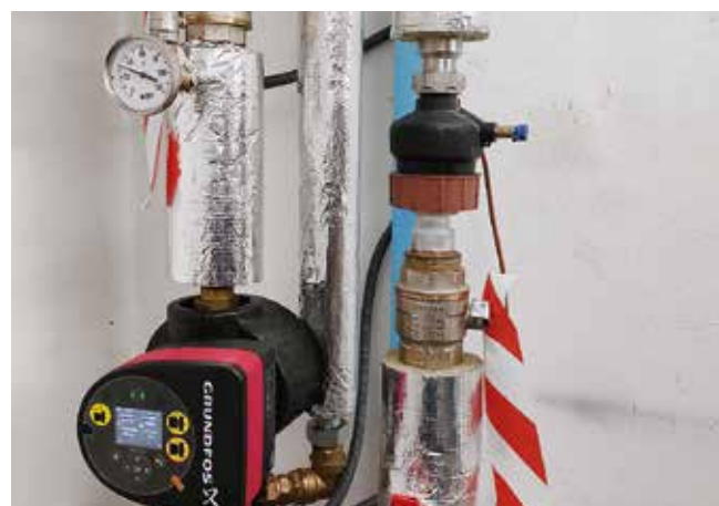
Čerpadlo s frekvenčním měničem - regulací otáček / typ MAGMA 3 /
