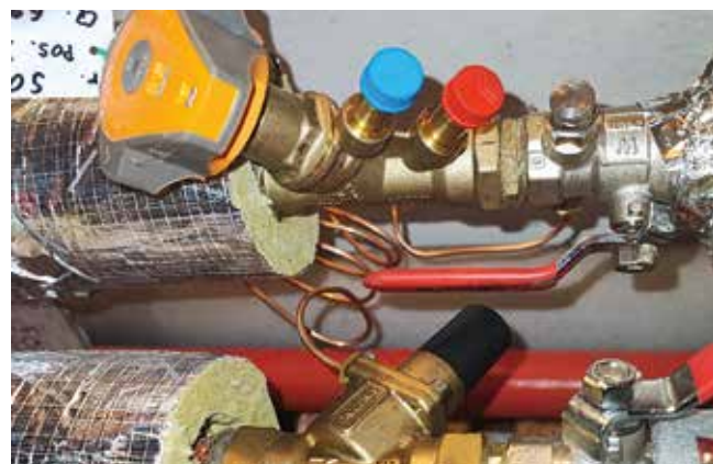
Vyvažovací ventily - umožňují přesné hydraulické vyvážení + měřící vsuvky pro měření průtoku / horní část foto / a plynule nastavitelný kompaktní regulátor tlakové diference
