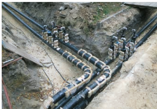
„Polštářování“ nových rozvodů tepla před jejich zásypem v Olomouci Neředíně.
