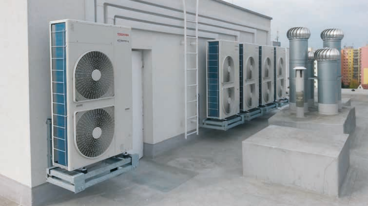
Bytový dům Brno, 60 bytových jednotek.
