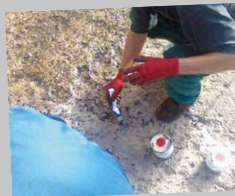
Nanášení penetrace
