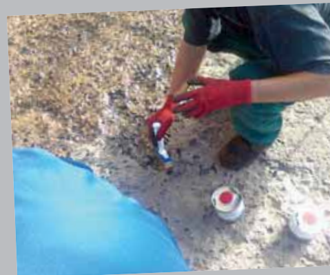
Nanášení penetrace
