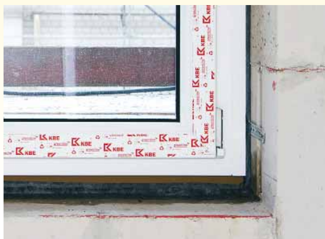
Na snímku okno spojené se stavbou kompresní páskou illmod Trio+ a v parapetní části fólií TwinAktiv.
