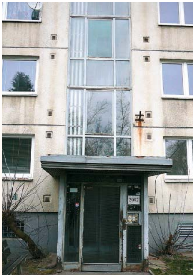
Jeden z mnoha domů, kde byla instalována tepelná čerpadla
