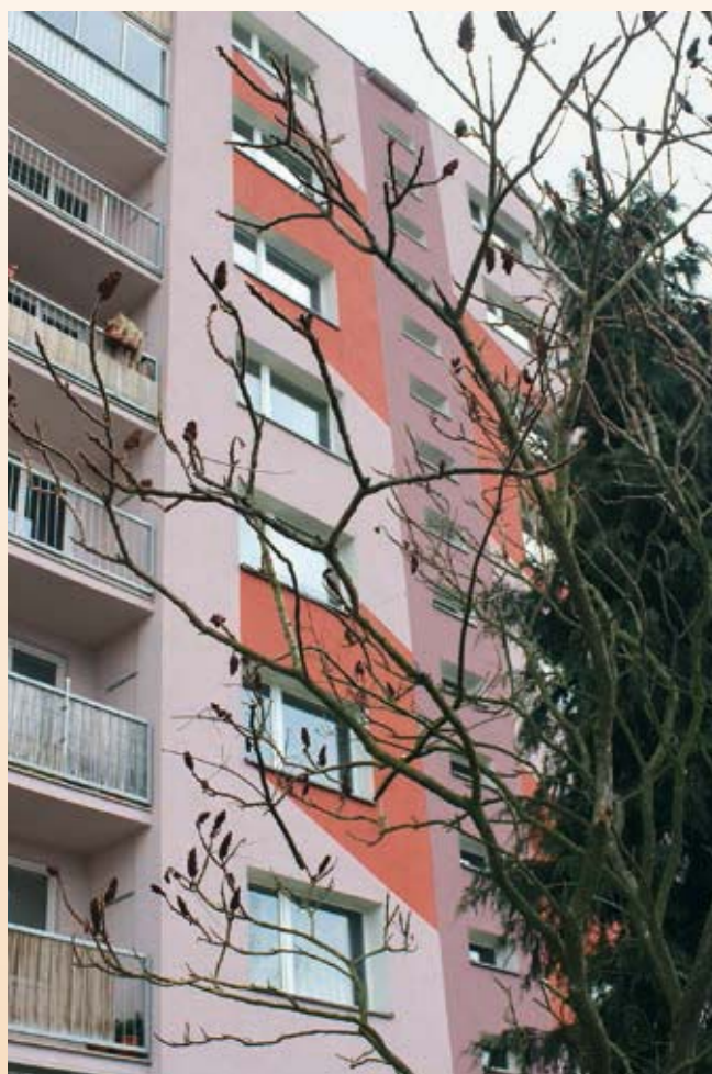
Po zateplení vypadají domy jako nové
