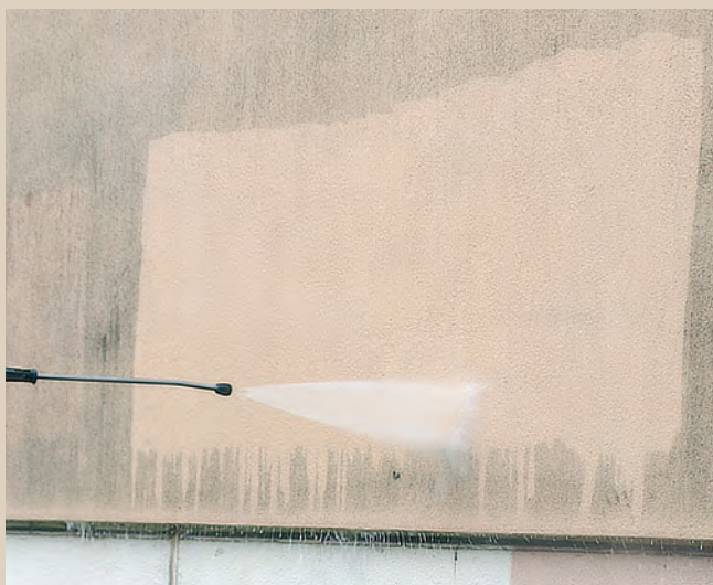
Blok 617: Tlaková voda ostříkuje místo předtím ošetřené odstraňovačem řas a mechtů. Rozdíl je viditelný. „Špína“ (řasy a mechy) byla odstraněna.
