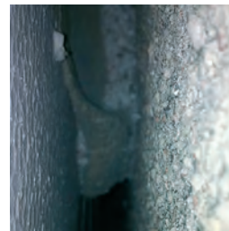
Obr.: Snímek z provedení sondy v místě lepení ETICS
