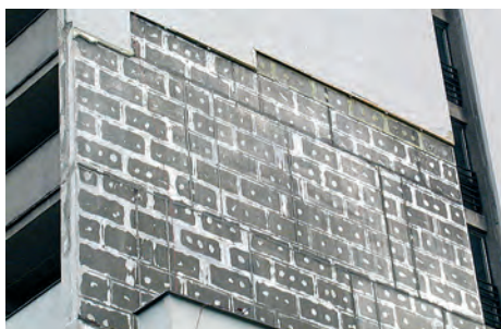
Obr.: Důsledky neřešení ztráty stability zateplovacího systému
