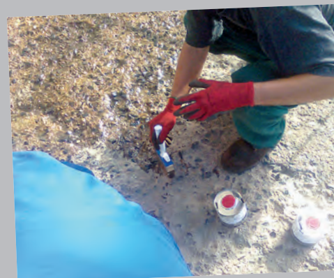
Nanášení penetrace
