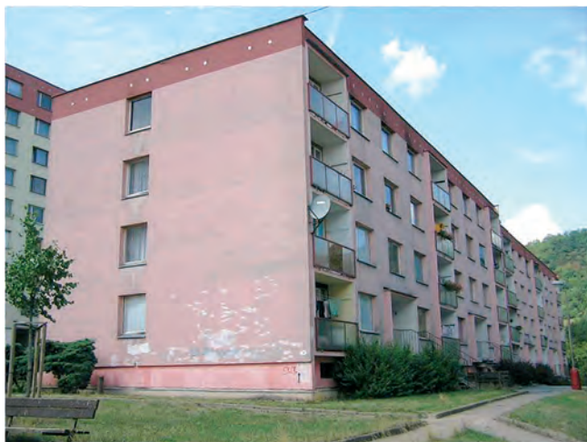
Pohled na dodatečně zateplený objekt s patrnými lokálními opravami poškozených míst
