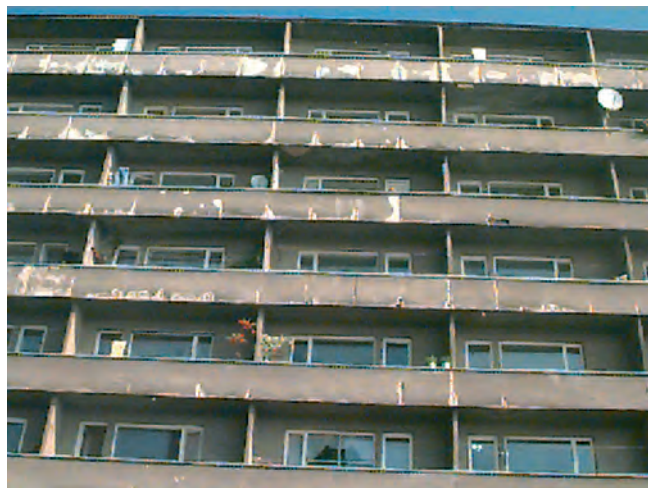
Náš dům před rekonstrukcí
