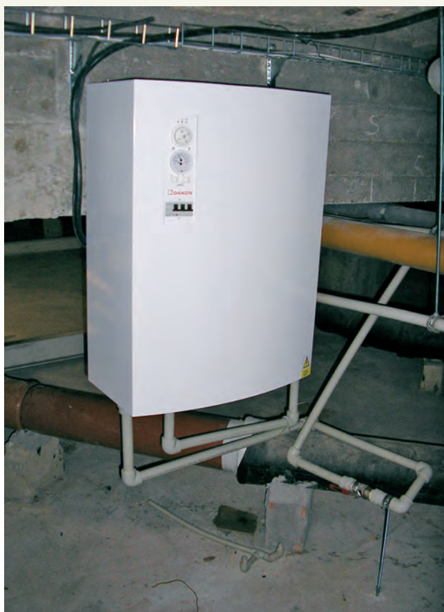
Záložní zdroj tepla - přímotopný kotel Dakon
