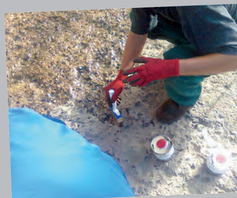
Nanášení penetrace
