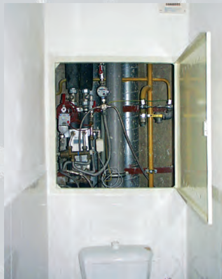
Obrázek 4b: Pohled do šachty. Zdroj: MEIBES.
