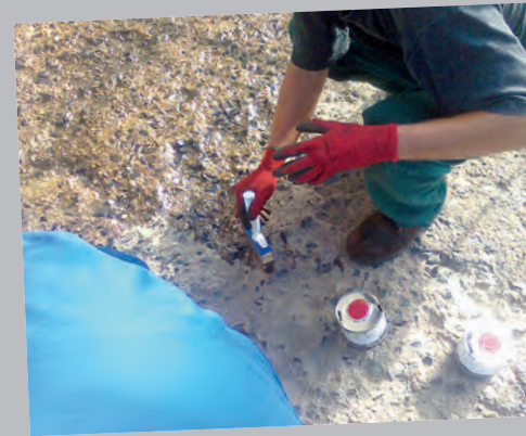
Nanášení penetrace
