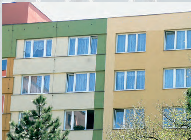
Obrázek 5: Dva způsoby rekonstrukce MIV: vlevo různá tloušťka okenních a parapetních pásů, vpravo vyhlazená fasáda. Zdroj: EkoWATT.
